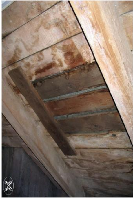
obr.č. 13: lokální výměna prken plného bednění
