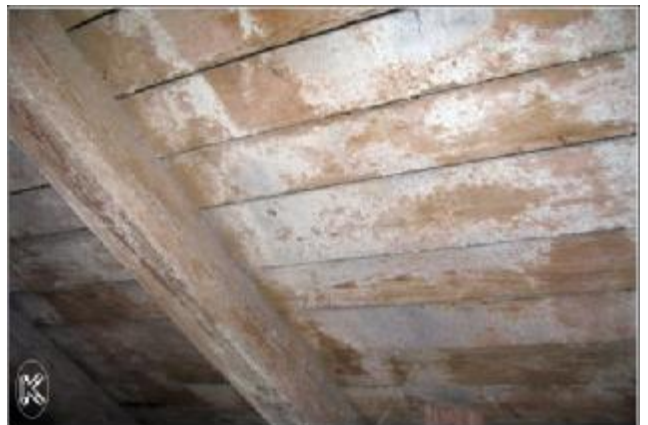
obr.č. 12: zbytky protipožárního nátěru na prknech plného bednění
